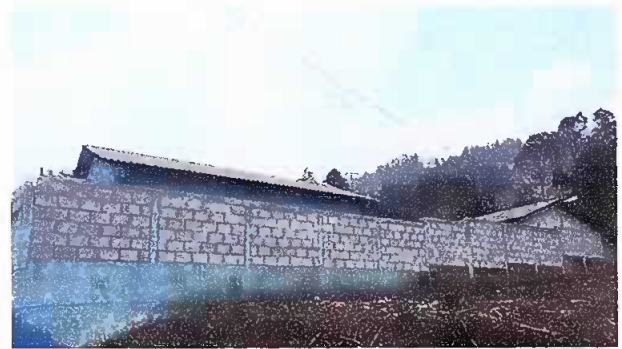
Foto 4: Sustitución del muro perimetral.
