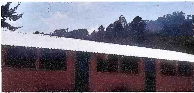
Foto 3: Sustitución de techo de aulas.
