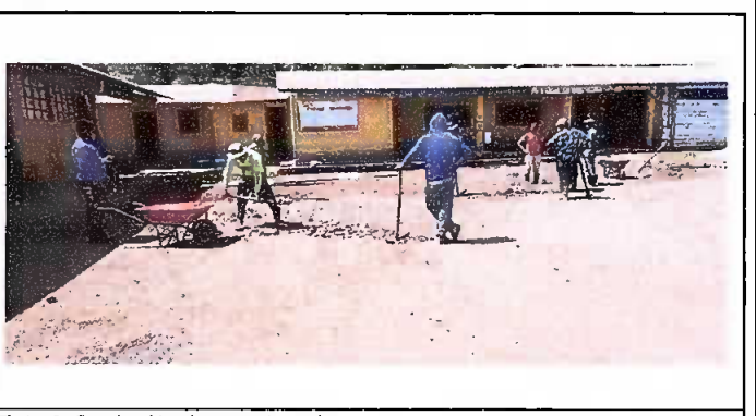
Foto 6: Sustitución de torta de patio
