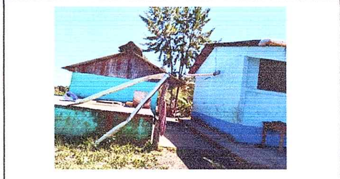
Foto 2: Sustrucción de tuberías.
