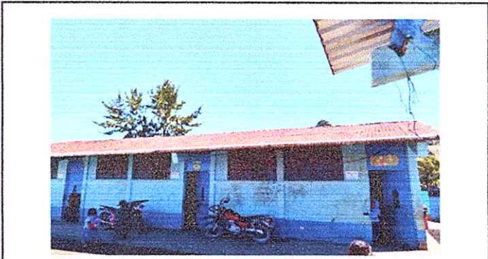
Foto 4: Sustitución de techo de aulas.
