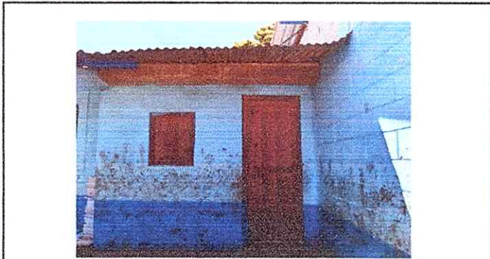
Foto 1: Sustitución de ventana y puerta de bodega.
