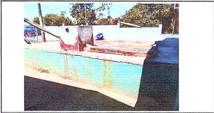
Foto 6: Sustituciones de tanques y tuberías para captación de agua.
