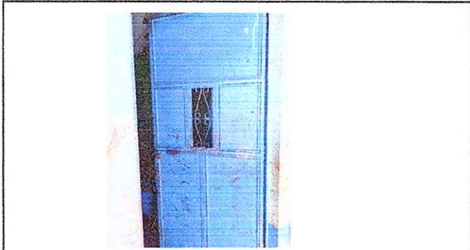
Foto 3: Sustitución de puertas de aulas.
