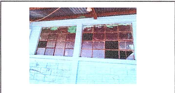
Foto 2: Sustitución de vidrios más colocación balcones.
