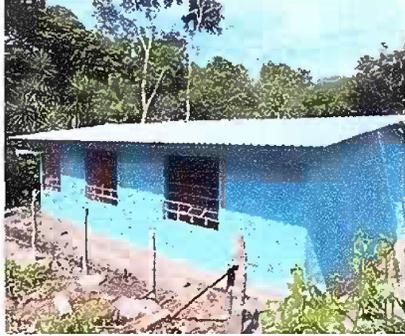
Foto1: Sustitución de lamina troquelada
