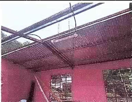
Foto 5: Sustitución de estructura de soporte de metal
