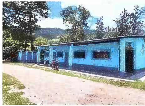
Foto 6: SUSTITUCIÓN DE PINTURA GENERAL
