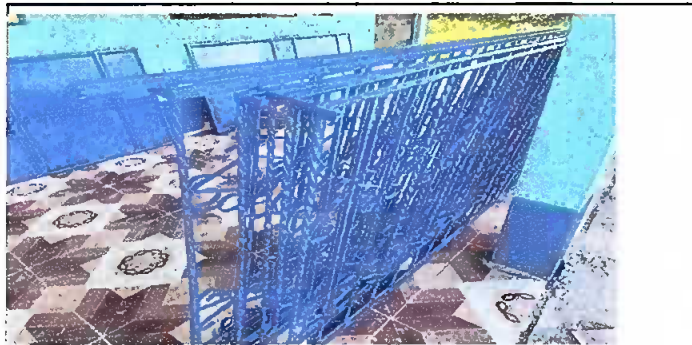
Foto 5: SUSTITUCION DE BALCONES DE METAL, ESTRUCTURAS METÁLICAS
