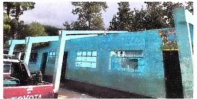
Foto 2: MÓDULO 1. proceso de entechado
