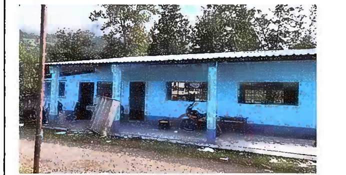
Foto1: MÓDULO 1. proceso de pintura general
