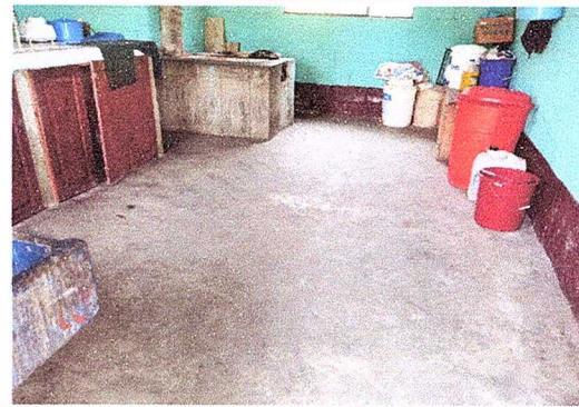
modulo 1. sustitucion de piso ceramico
