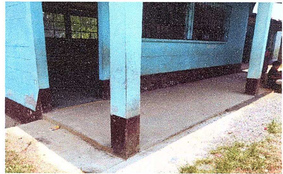
modulo 2 sustitucion de vidrios y pintura general
