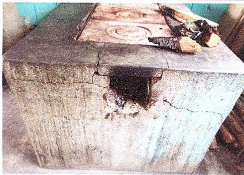
MODULO 1. sustitucion de estufa
