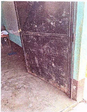
MODULO 1. sustitucion de puertas en modulo 1
