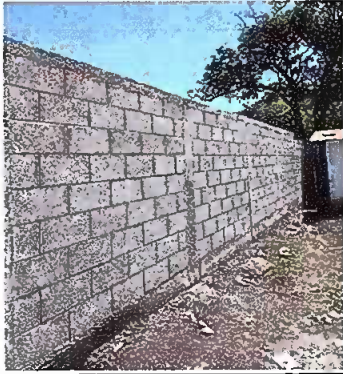
Foto 1: Fase final del muro perimetral.
