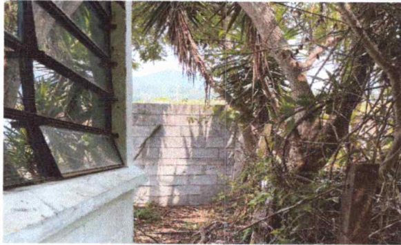
Foto1: Reparación de muro perimetral
