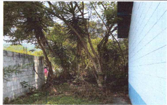
Foto 2: reparación muro perimetral
