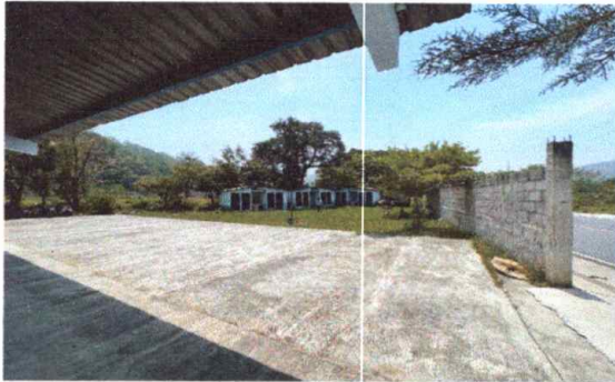
Foto 3: Reparación de muro perimetral
