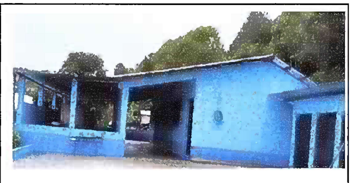
Foto 6: Modulo 2: Pintura general exterior e interior.
