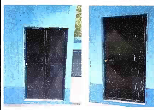
Foto 2: Modulo 1: Sustitución de Chapa, mantenimiento de estructura de puerta
