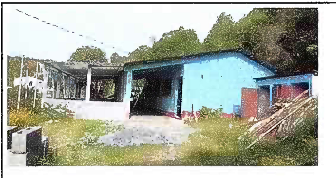
FOTO 6. MODULO 2: Pintura general
