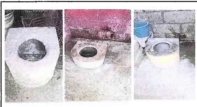
FOTO 4. MODULO 2: Sustrucion de inodoro e instalacion.
