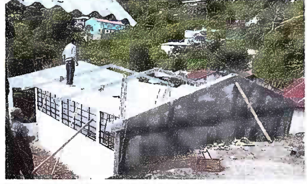
Foto 2: SUSTITUCIÓN DE ESTRUCTURA DE METAL
