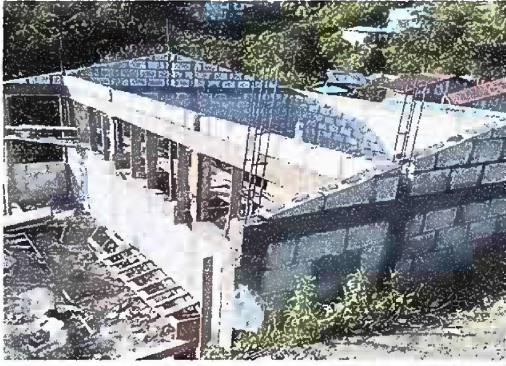
Foto1: REPARACIÓN DE PARED
