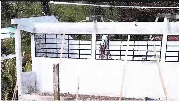
Foto 5: COLOCACIÓN DE VENTANAS DE ESTRUCTURA DE METAL
