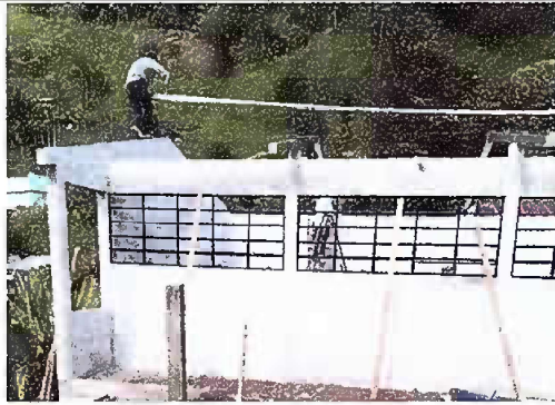
Foto 3: COLOCACIÓN DE COSTANERAS
