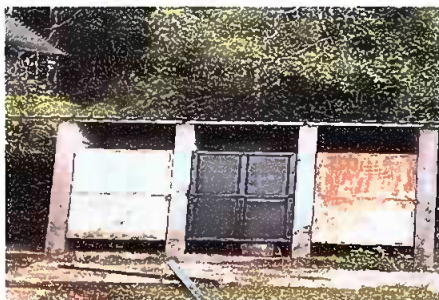
Foto1: sustitucion de puerta y techado
