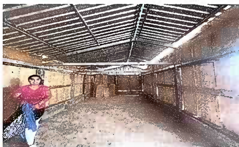
Foto 5: SUSTITUCION DE TECHO DE PAREDES Y LATERALES Y PISO
