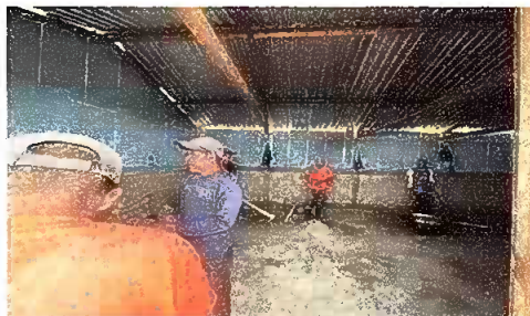
FOTO 6: SUSTITUCION DE LAMINA Y PISO
