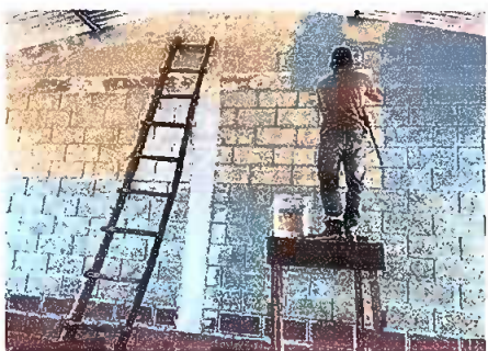
FOTO 3: PINTADO DE PAREDES A TODAS LAS AULAS POR DENTRO Y FUERA
