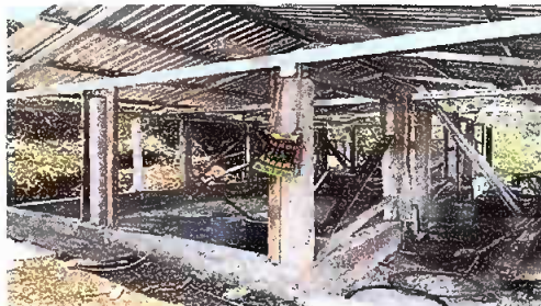
FOTO 2: SUSTITUCION TECHO Y PILARES
