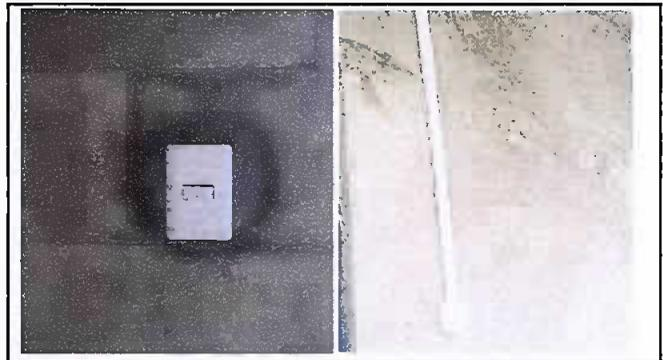
Foto 10: Instalación de unidades de luz (interruptor, ducto y cables)
