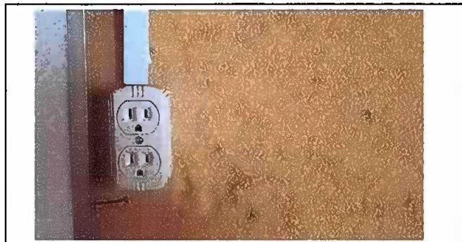
Foto 11: Instalación de unidades de fuerza (tomacorrientes y cable eléctrico)
