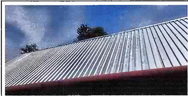
Foto 3: Sustitución e instalación de laminas troquelada aluzinc
