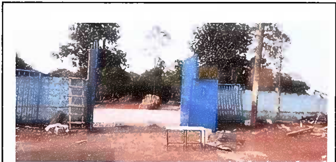
Foto 6: Sustitución de porton
