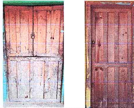
Foto 6: Sustrucción de puerta
