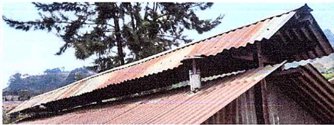
Foto 3: Sustrucción de capote de lámina para lámina troquelada
