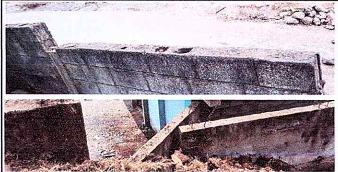
Foto 4: Reparación de muro perimetral
