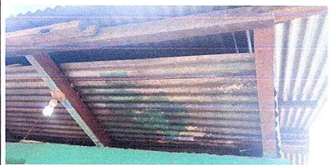
Foto 2: Sustrucción de estructuras de soporte de madera
