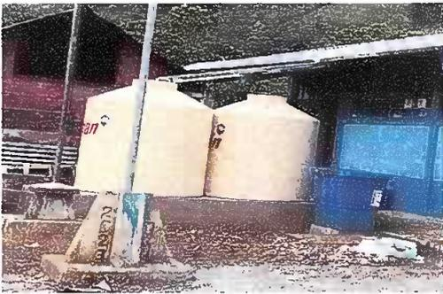
FOTO 5: SUSTITUCIÓN DE DEPÓSITOS DE AGUA
