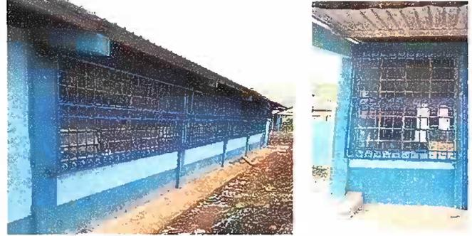
FOTO 2: FABRICACION E INSTALACION DE BALCONES DE HIERROS EN VENTANAS
