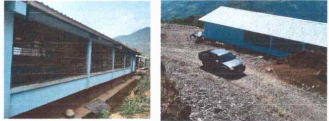
FOTO 2 MODULO 1: FABRICACION E INSTALACION DE BALCONES DE HIERROS EN VENTANAS
