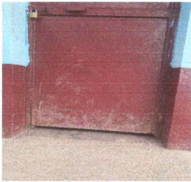
FOTO 3 MODULO 1: SUSTITUCION DE PUERTAS DE METAL
