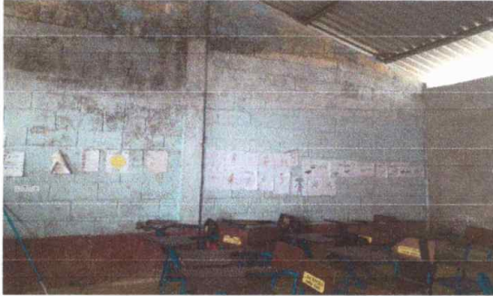
FOTO 1 MODULO 1 :PINTURA EN MUROS EXTERIORES E INTERIORES
