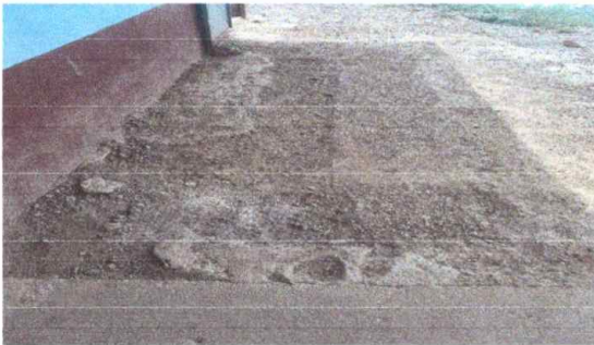
FOTO 5 MODULO 1: REPARACION DE PLANCHAS DE CONCRETO DE PATIO
