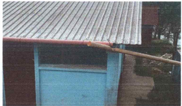
FOTO 4 MODULO 1 : SUSTITUCION DE CANALES DE PVC
