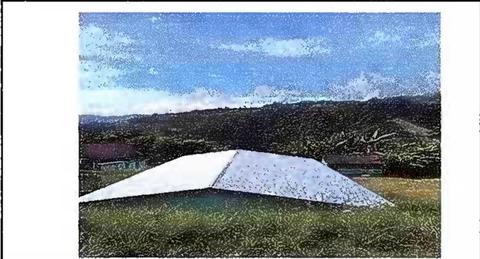
Foto1: MODULO I: Sustrucción de lámina por lámina troquelada calibre 26
