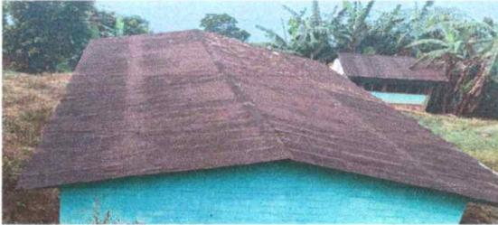
Foto1: MODULO I: Sustitución de lámina por lámina troquelada calibre 26
