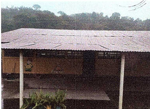
Foto 5: módulo 2 sustitución de torta de concreto
