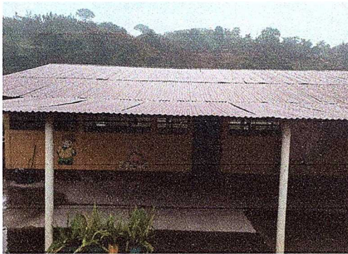
Foto 3: módulo 1 sustitución de lámina por lámina troquelada
