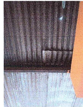
Foto 2: modulo 2 sustitución d elámina por lámina troquelada
