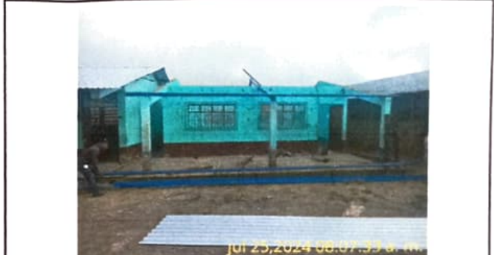
Foto 2: Poniendo la estructura metálica que soporta la lámina
