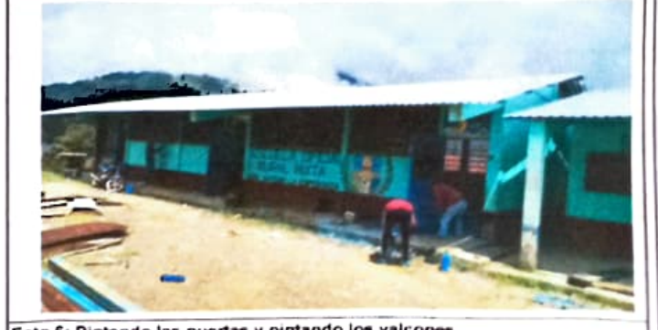
Foto 6: Pintando las puertas y pintando los valcones
