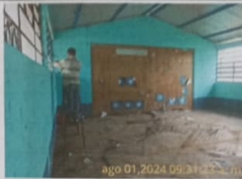
Foto 4: cambiando vidrios en ventanales
