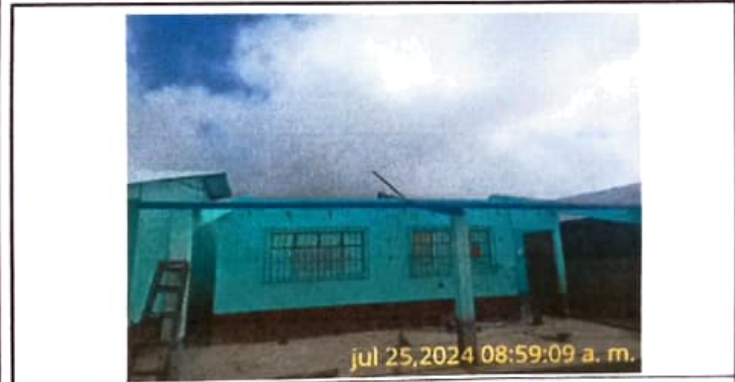
Foto 3: Instalando costaneras en modulo 2.
