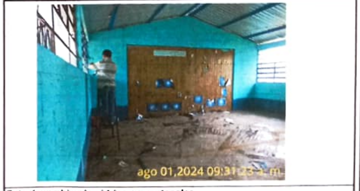
Foto 4: cambiando vidrios en ventanales
