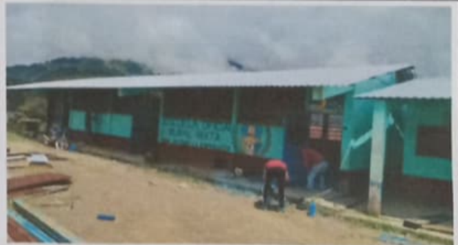
Foto 6: Pintando las puertas y pintando los valcones
