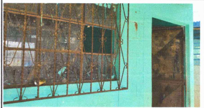
Foto 2: MODULO 2. Mantenimiento de los balcones, ventanales y puerta. Sustitución de Vidrios
