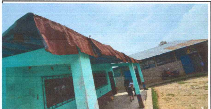
Foto 4: MODULO 2. Sustitución de la lamina por lamina troquelada aluzinc y de la estructura de metal. Mantenimiento de los balcones, ventanales y puerta. Sustitución de vidrios
