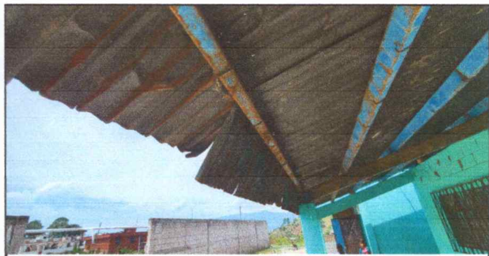
Foto 6: MODULO 2 Sustitución de la lamina por lamina troquelada aluzinc y de la estructura de metal. Mantenimiento de balcones, ventanas y sustitución de vidrios.
