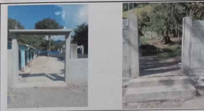
Foto 5: Espacio donde se instalarán los portones.
