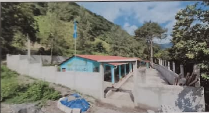
Foto 3: Vista panorámica de muro perimetral que se encuentra frente al establecimiento.
