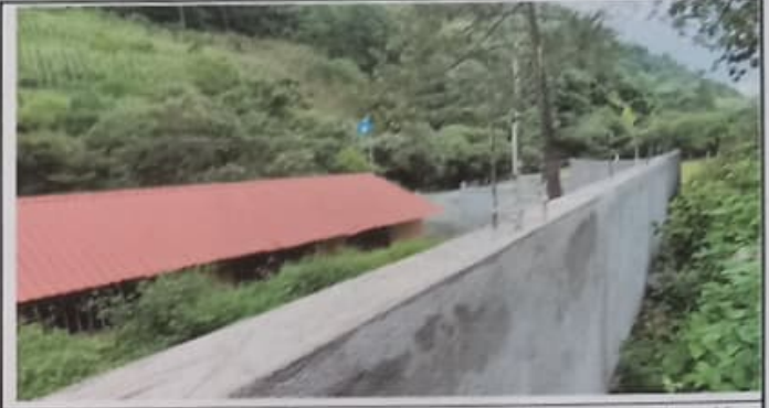
Foto 2: columnas y pared reforzadas y repelladas del muro de contención.
