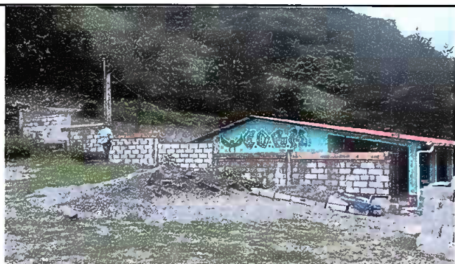
Foto 3: Prosedimiento de muro perimetral que se encuentra frente al establecimiento.
