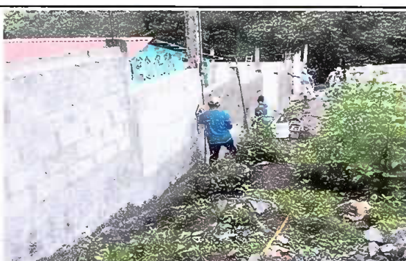
Foto 4: Aplicación de repello de muro perimetral del establecimiento con vista desde la calle que pasa a un costado.
