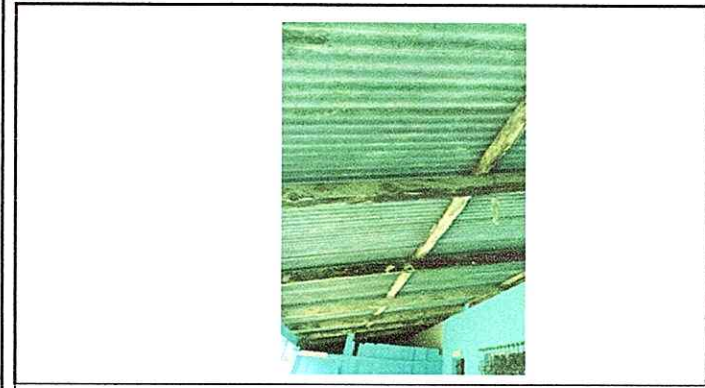
MODULO 1: SUSTITUCIÓN DE ESTRUCTURA DE SOPORTE DE MADERA, POR ME
