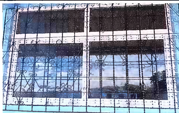
Foto 4: Sustrucion de estructura de ventana y vidrios
