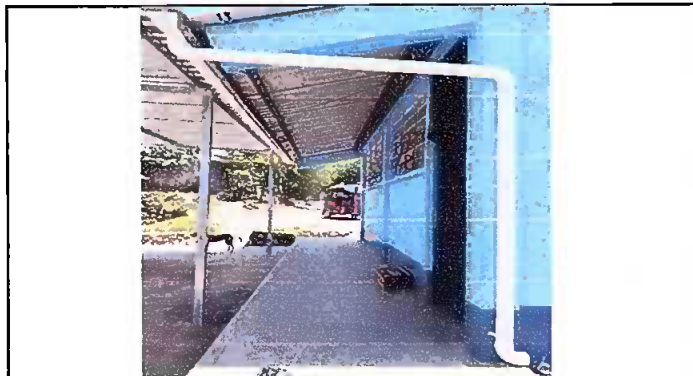
Foto1: Sustrucion de canales y bajadas
