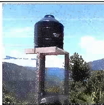
Foto 6: Siustrucion de deposito de agua
