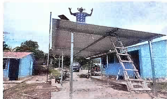
Foto 12: Siustrucion de estructura de soporte y lamina
