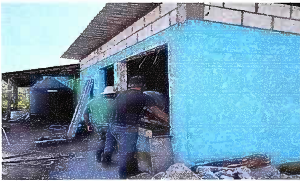
Foto 9: Apertura de vano y sustrucion de ventana
