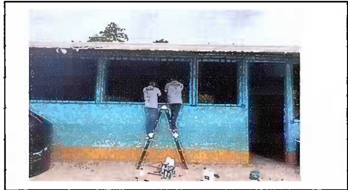
Foto 4: Sustitucion de estructura de ventana y vidrios
