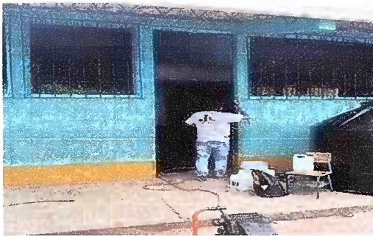
Foto 11: Mantenimiento de estructura de puerta lijado y aplicacion de pintura
