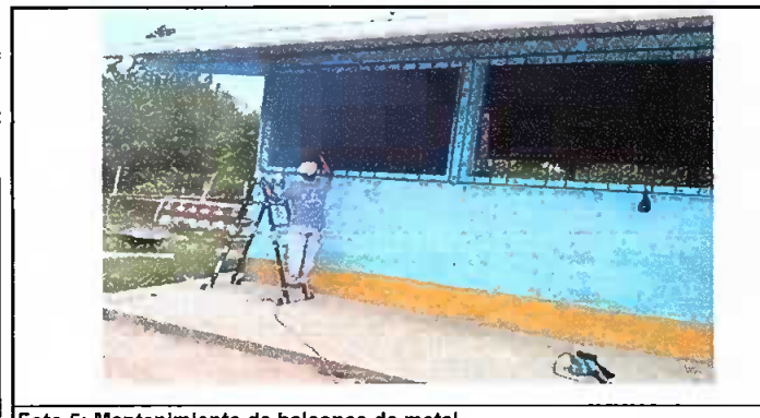
Foto 5: Mantenimiento de balcones de metal
