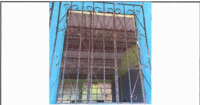
Foto 5: Mantenimiento de balcones de metal
