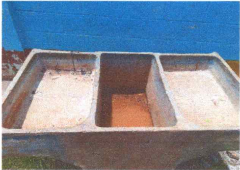
Foto 7: sustitución de pila
