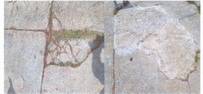
Foto 10: sustitución de piso de torta de concreto
