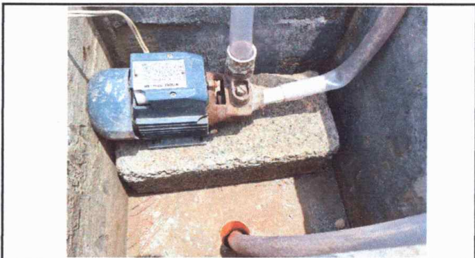
Foto 2: Sustitucion de bomba de agua
