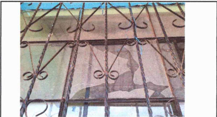
Foto 4: Sustitucion de estructura de ventanas y vidrios
