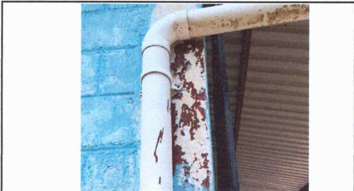
Foto 3: Pintura de paredes exteriores e interiores
