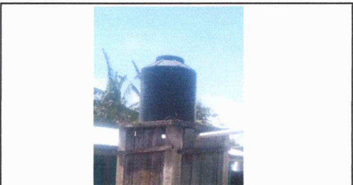
FOTO 6: Sustitucion de deposito de agua
