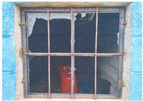
Foto 9: apertura de vano y sustitución de ventana
