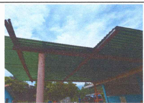
Foto 12: Sustitución de Estructura de soporte y lamina
