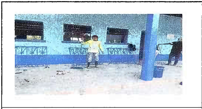
Foto 5: sustitución de vidrios y balcones en proceso
