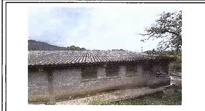
Foto1: Modulo 1 Sustitución de lámina del techo.
