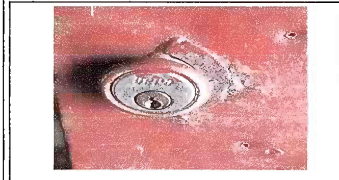
Foto 3: Modulo 1 Sustitución de chapa
