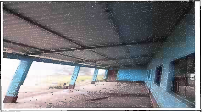
Foto 2: Sustitución de estructura de soporte y lámina.
