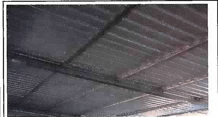
Foto 3: Sustitución de estructura de soporte.
