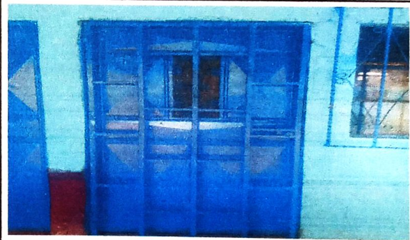
Foto 4: Proceso de mantenimiento de puertas
