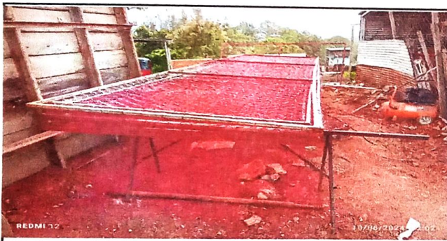
Foto 3: Preparacion de malla
