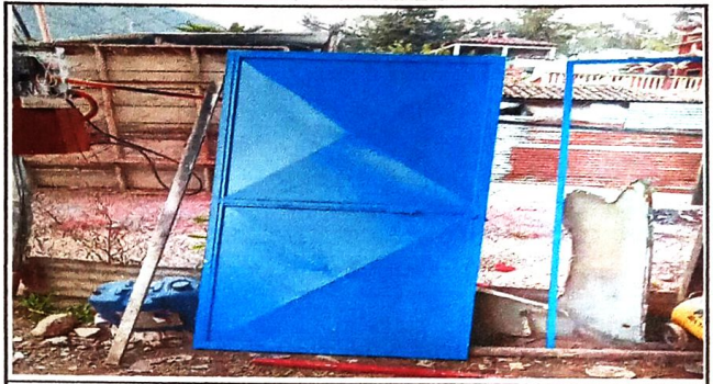
Foto 2: Proceso de preparacion de puerta
