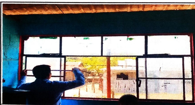
Foto 5: Medida y sustitucion de vidrios
