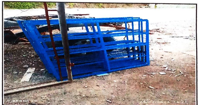
Foto 6: Preparacion de ventanas
