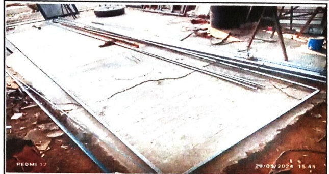
Foto 2: Proceso de preparacion de tubo.
