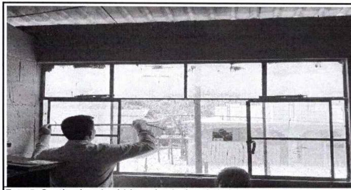
Foto 5: Sustitucion de vidrios e instalacion de balcon
