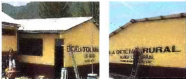
Foto 5: Sustitución de pintura de centro educativo.
