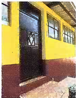
Foto 3: Apertura e instalación de puertas
