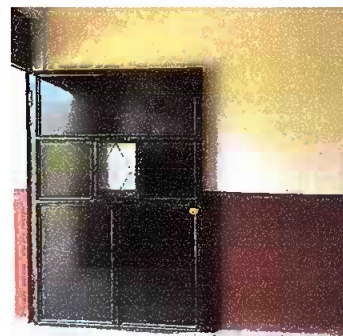
Foto 4: Apertura e instalación de puertas
