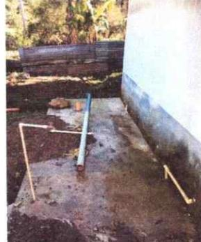
Foto 2: Sustitución de tuberías de aguas Pluviales
