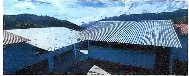
Foto 2: Sustitucion de lamina por lamina troquelada calibre 23 y 26 en modulos 1 y 2
