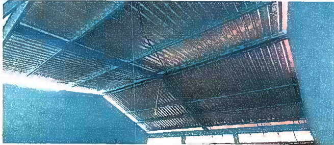
Foto1: Mantenimiento de estructuras de soporte de metal en modulos 1 y 2
