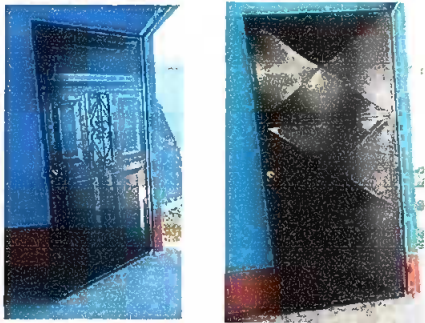
Foto 3: Mantenimiento de puerta y Fabricacion e Instalacion de puertas de metal
