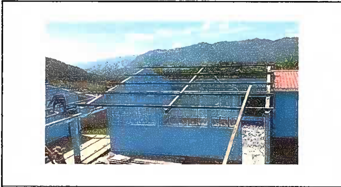
Foto 2: Mantenimiento de estructuras metalicas modulo 1 y 2
