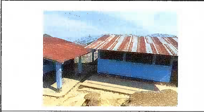
Foto1: Sustitución de lamina por lamina troquelada modulo 1 y 2
