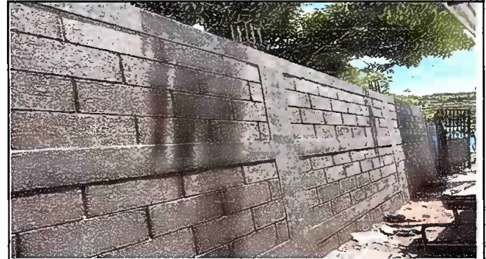
Foto 4: Culminacion de Muro lado sur
