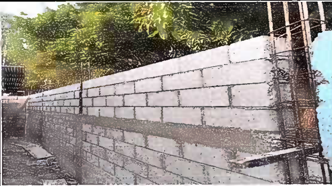
Foto 1: levantado de Muro Perimetral, lado sur
