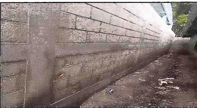
Foto 5: Muro perimetral lado oeste 40mts. De largo X 3 de alto.
