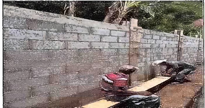
Foto 2: levantado de Muro Perimetral lado oeste
