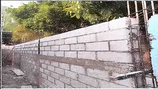
Foto1: levantado de Muro Perimetral, lado sur
