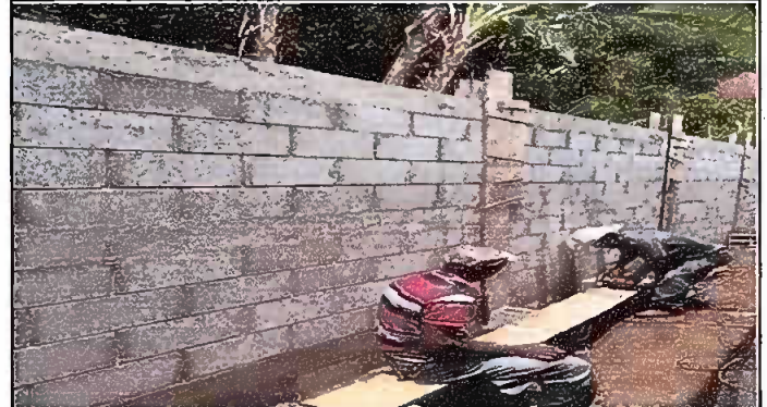
Foto 2: levantado de Muro Perimetral lado oeste
