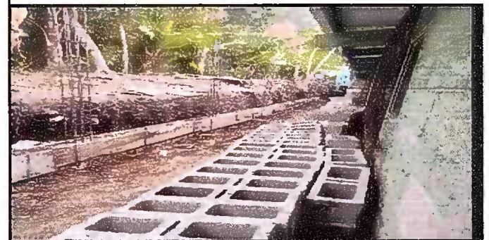
Foto 6: Terminando la solera de humedad.
