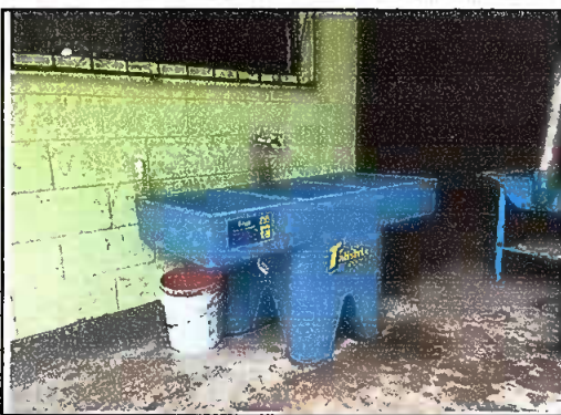
Foto 5: Sustitución de pila
