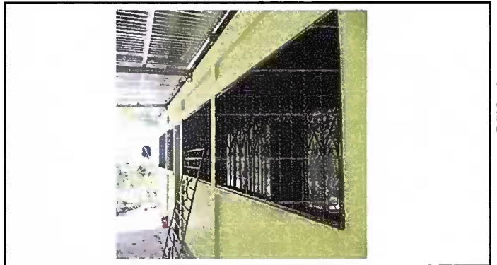
Foto 2: Sustitución de vidrios
