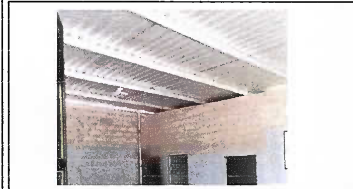
Foto1: SUSTITUCION DE LAMINA
