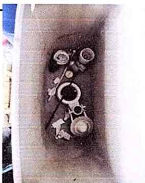
Foto 5: Sustitucion de accesorios de inodoro(contrallave, tubo de abasto, y tanque)
