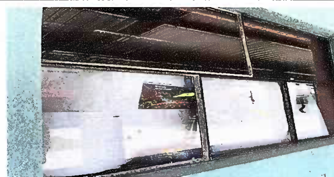
Foto 5: SUSTITUCIÓN DE VIDRIOS
