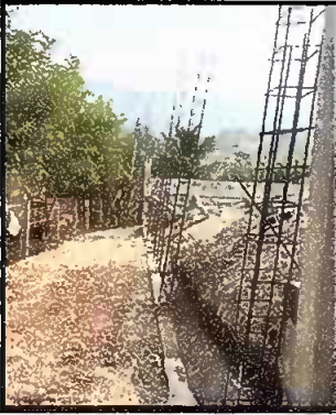
Foto1: Reparación de Muro de contención
