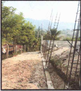
Foto 1: Reparación de muro de contención
