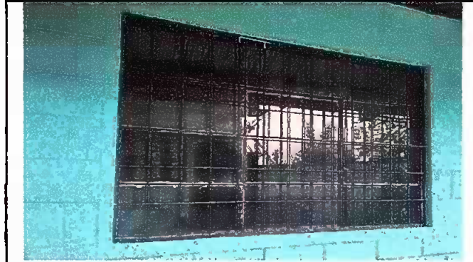
Foto 2: Modulo 1. Sustitución de vidrios.
