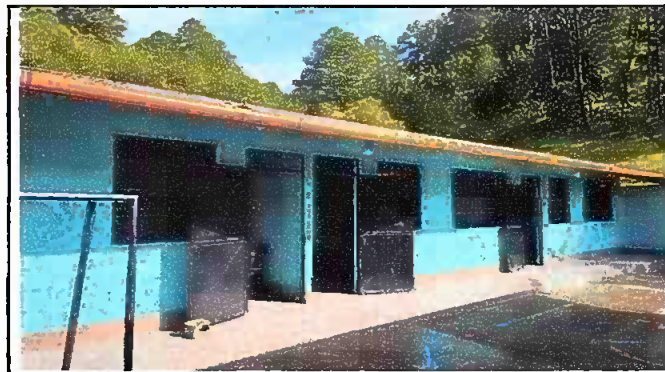
Foto 4: Modulo 1. Sustitución de canal de pvc.
