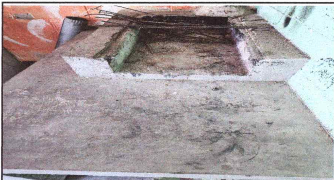
Foto 4. Modulo 1. Sustitución de estufa rural (completa) incluye chimenea y plancha de metal.
