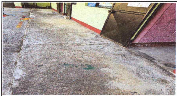
Foto 2. Modulo 1: Sustitucion de piso de torta de concreto por piso ceramico.
