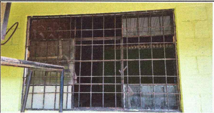
Foto 5. Modulo 1: Sustitución de vidrios.
