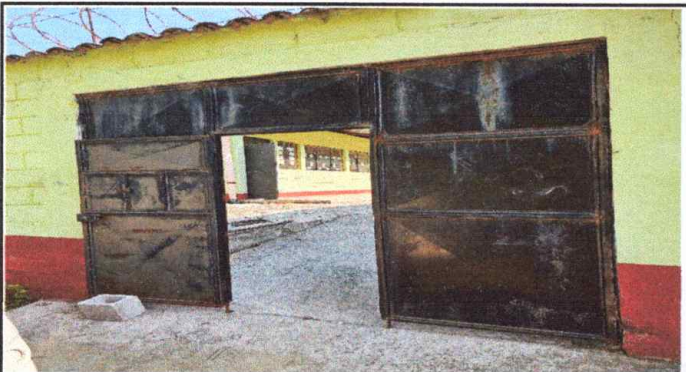
Foto 3. Muro perimetral. Mantenimiento a portones de metal
